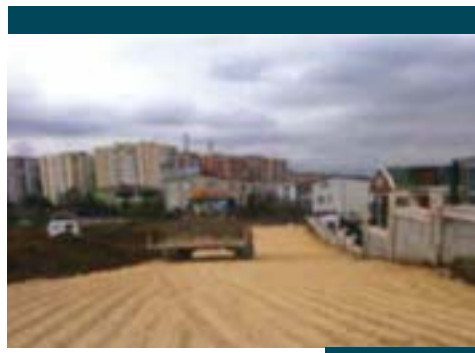
GÜZELCE MAHALLESİ – 217.SOKAK
