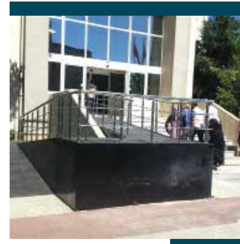
BÜYÜKÇEKMECE EMNİYET MÜDÜRLÜĞÜ ENGELLİ RAMPASI YAPILMASI
