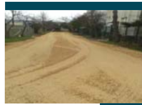
CELALİYE MAHALLESİ – MUTLU 1 SOKAK
