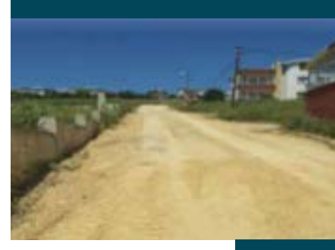
BAHÇELİEVLER MAHALLESİ – NİLÜFER SOKAK
