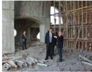
23.01.2015 MIMARSINAN MERKEZ CAMİİ İNŞAATI BARTIN MİLLETVEKİLİ RIZA YALÇINKAYA İLE BİRLİKTE İNCELEME
