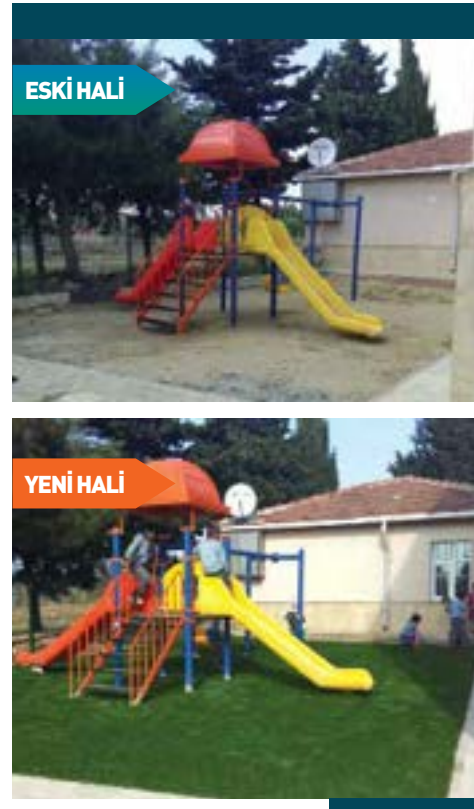
ESKİCE ADNAN KAHVECİ İ.Ö.O. PARK YAPIM İŞİ
