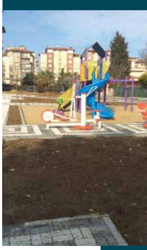
İPEKÇİ SOKAK PARK YAPIM İŞİ
