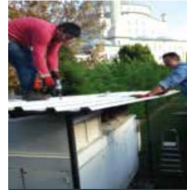
Kültür Müdürlüğü'nün Kullanımında Olan Jeneratöre Yağmurdan Koruma Çatısı Yapıldı
