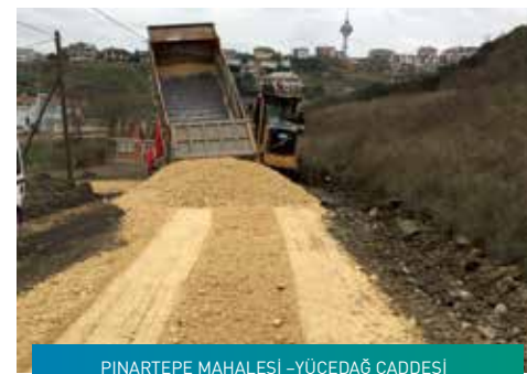
PINARTEPE MAHALLESİ – YÜCEDAĞ CADDESİ
