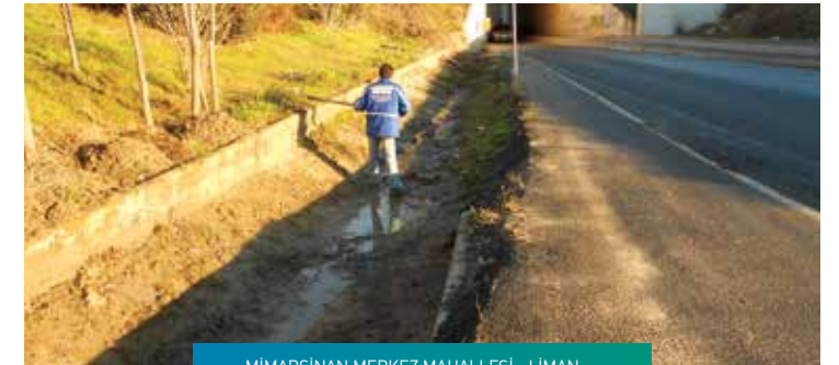
MIMARSINAN MERKEZ MAHALLESİ – LİMAN
