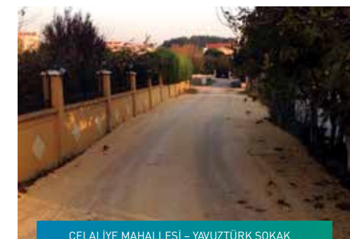
CELALİYE MAHALLESİ – YAVUZTÜRK SOKAK
