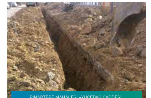
PINARTEPE MAHALLESİ – YÜCEDAĞ CADDESİ
