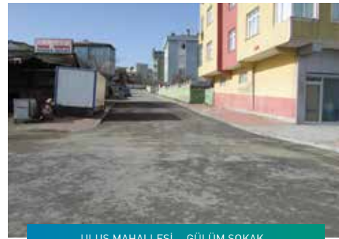
ULUS MAHALLESİ - GÜLÜM SOKAK
