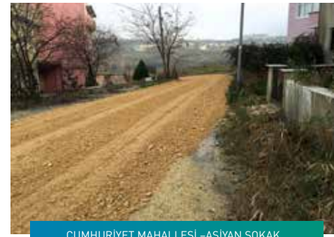
CUMHURİYET MAHALLESİ – AŞIYAN SOKAK
