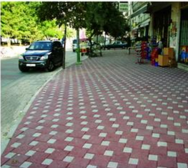
Parke Taşı döşeme çalışmaları
