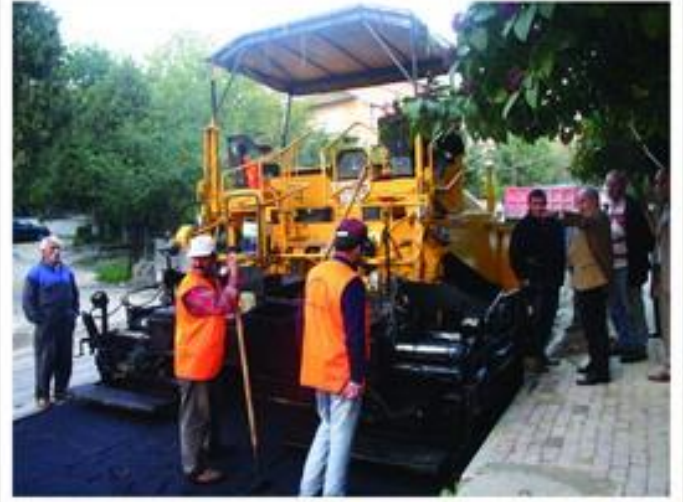
Belediye Başkanı Dr. Hasan AKGÜN asfalt döşeme çalışmaları kontrolü sırasında
