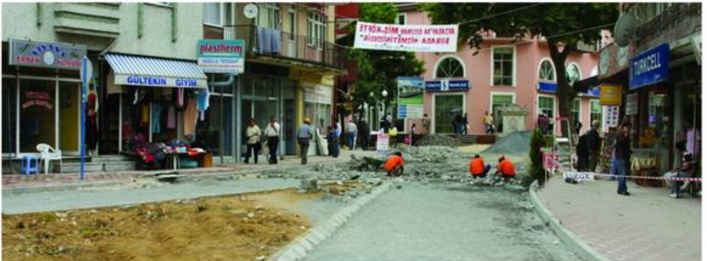
Asfalt ve Kilit Taş çalışmaları
