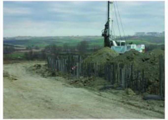
Fore Kazık Çakma Çalışmaları
