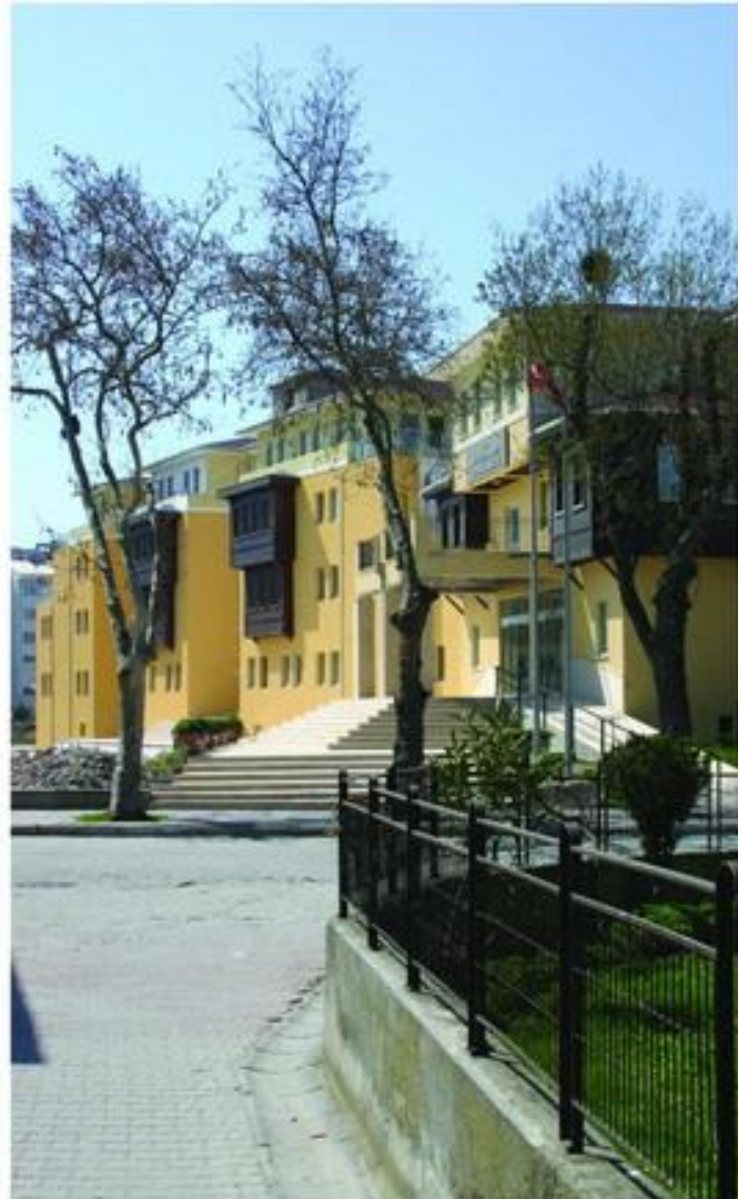
Kaymakamlık Hizmet Binası
