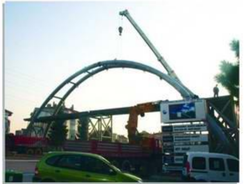
Üst Geçit inşaatından görünüm.
