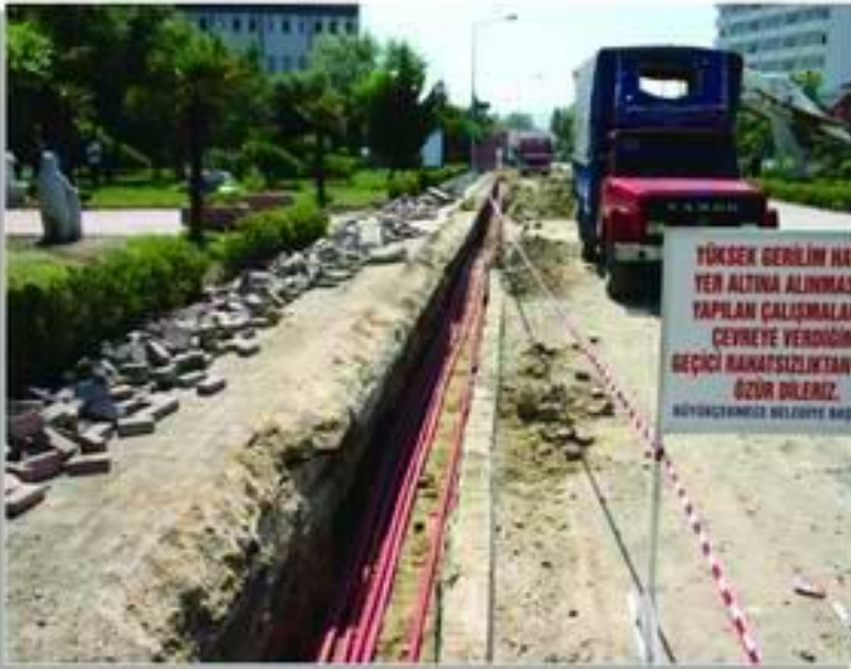
Yüksek Gerilim Hatları Yer Altına Alınma Çalışmaları.
