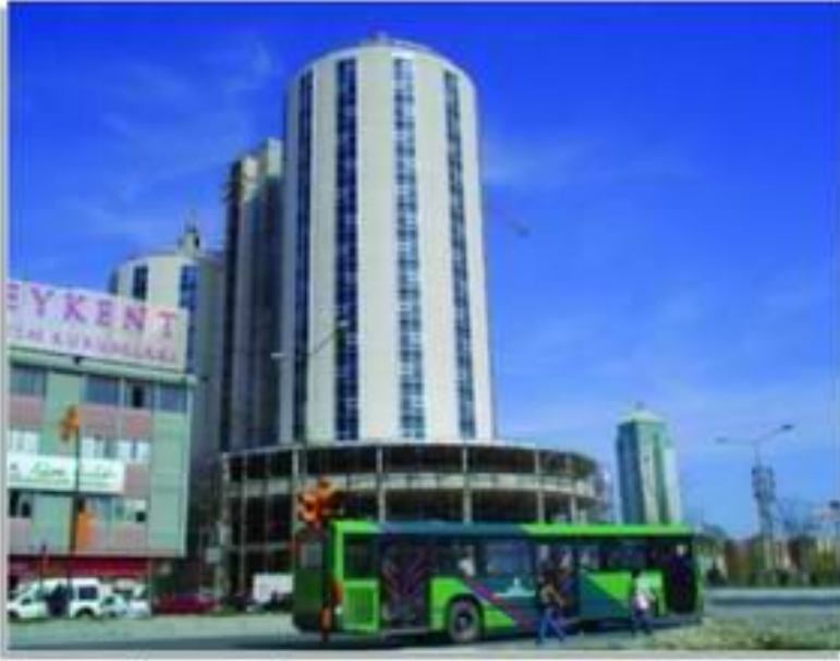
Milenyum İş Merkezi İnşaatından görünüm.
