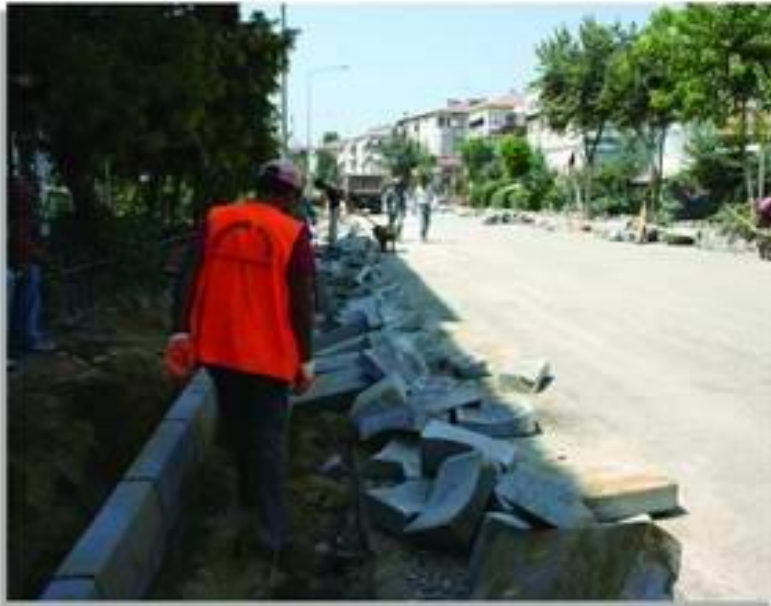
Tretuar ve Asfalt Çalışmaları.
