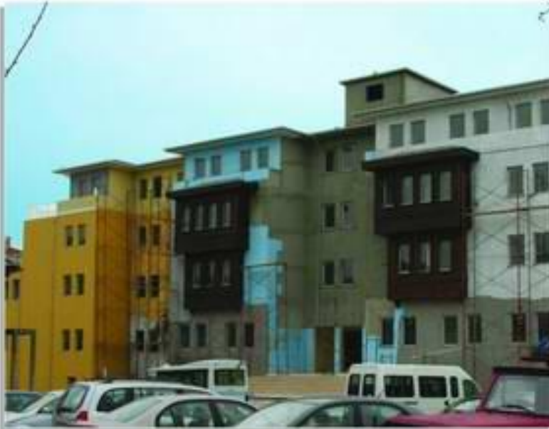
Kaymakamlık Hizmet Binası 2. Bölüm İnşaatı devam etmektedir.
