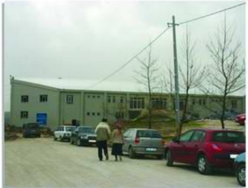
Kapalı Spor Salonu inşaatından görünüm
