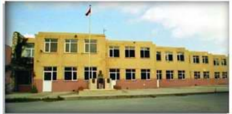
1999 depreminde hasar gören Yavuz Selim İlköğretim Okulu'nun eski görünümü
