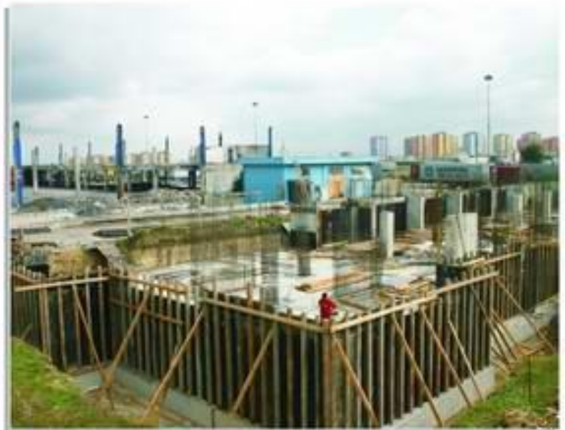
Recep Güngör Çok Programlı Lisesi inşaatı
