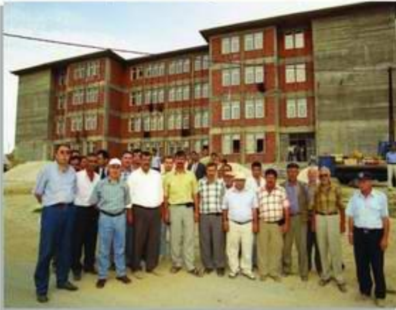
Çakmaklı Cumhuriyet Lisesi ve İlköğretim Okulu inşaatı
