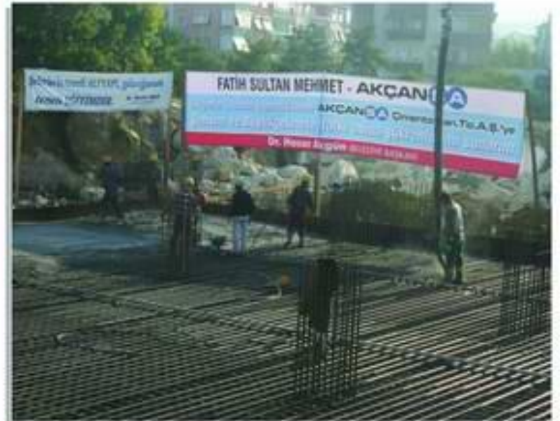
F.S. Mehmet AKÇANSA İlköğretim Okulu İnşaatı.
