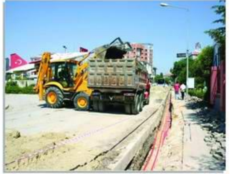
Yüksek Gerilim Hatlarının uygulaması
