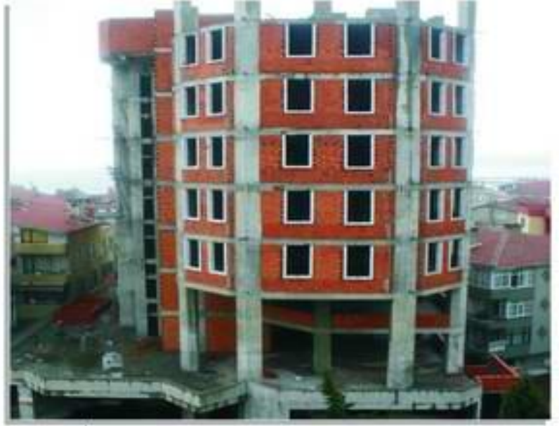
Belediye İş Merkezi İnşaatından görünüm.
